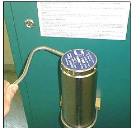
Abb. 1 - Abschrauben des Filtergehäuse-Deckels
