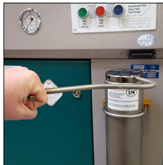
Abb. 2 - Abschrauben des Filtergehäuse-Deckels
