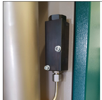
Druckhalte- / Rückschlagventil
