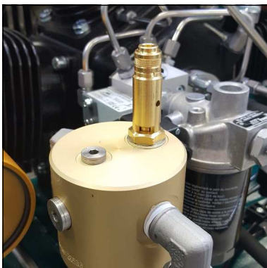
Sicherheitsventil 1. Stufe
