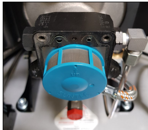
Abb. 2 - Einbaulage Ölsieb
