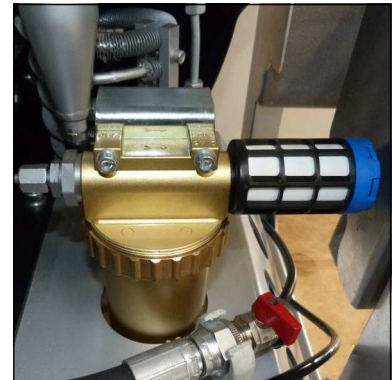
Öl- / Wasserabscheider Endstufe
