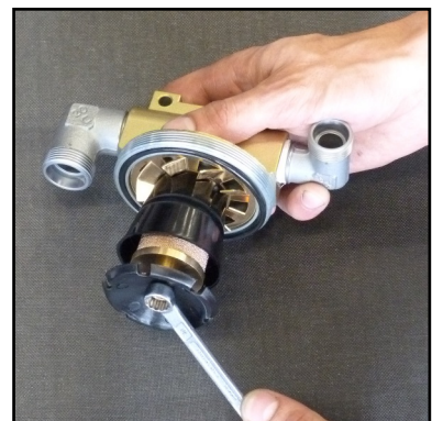
Abb. 2 - Mutter am Oberteil lösen
