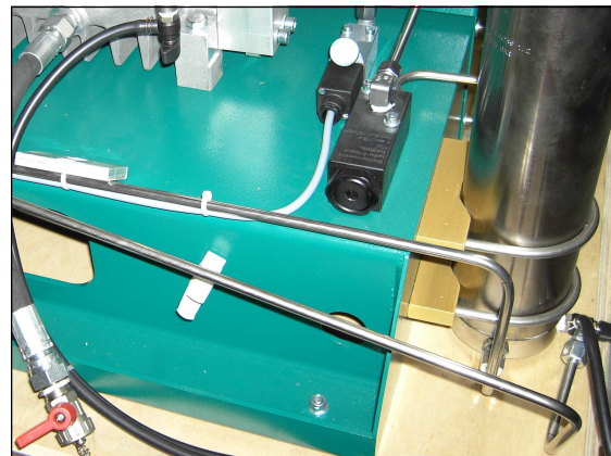
Zu entfernende Rohrleitung
